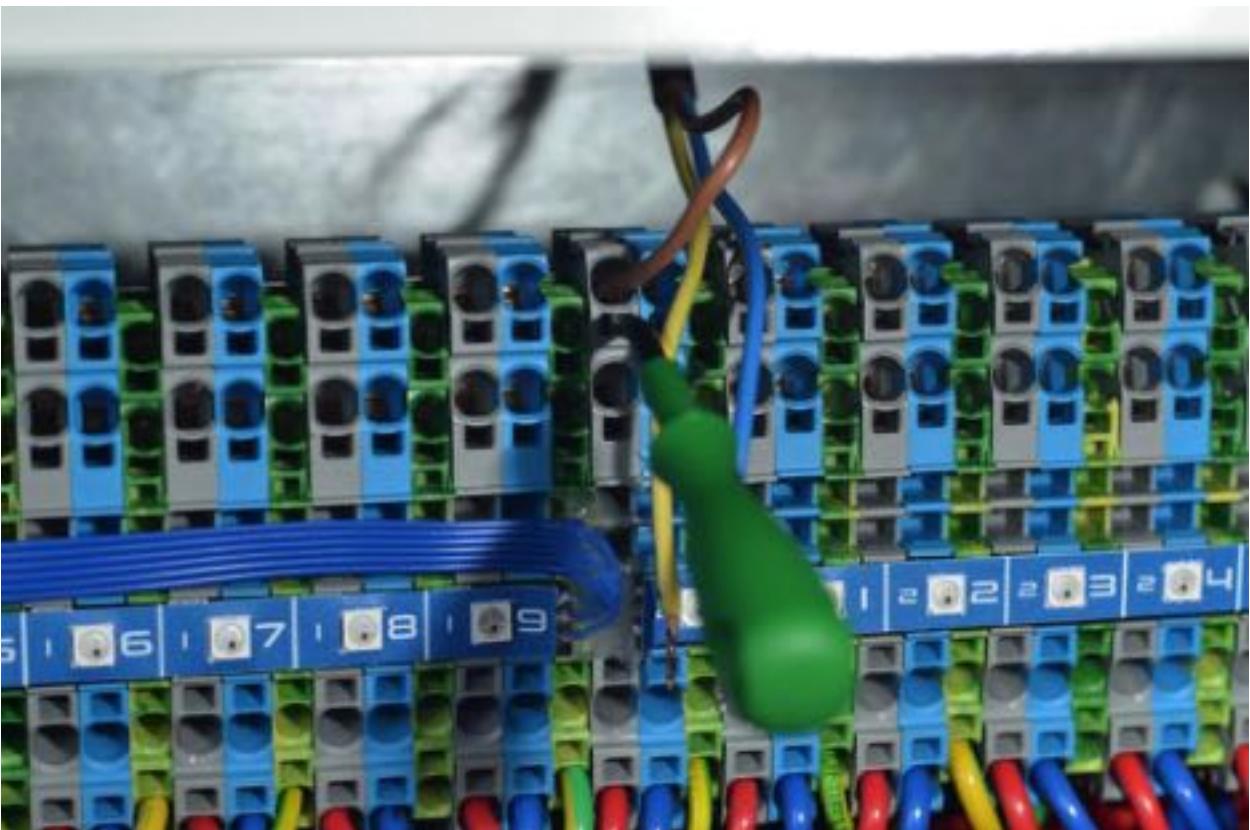
Рисунок 2.3.17. Подключаем кабель (фаза) на выводе.
