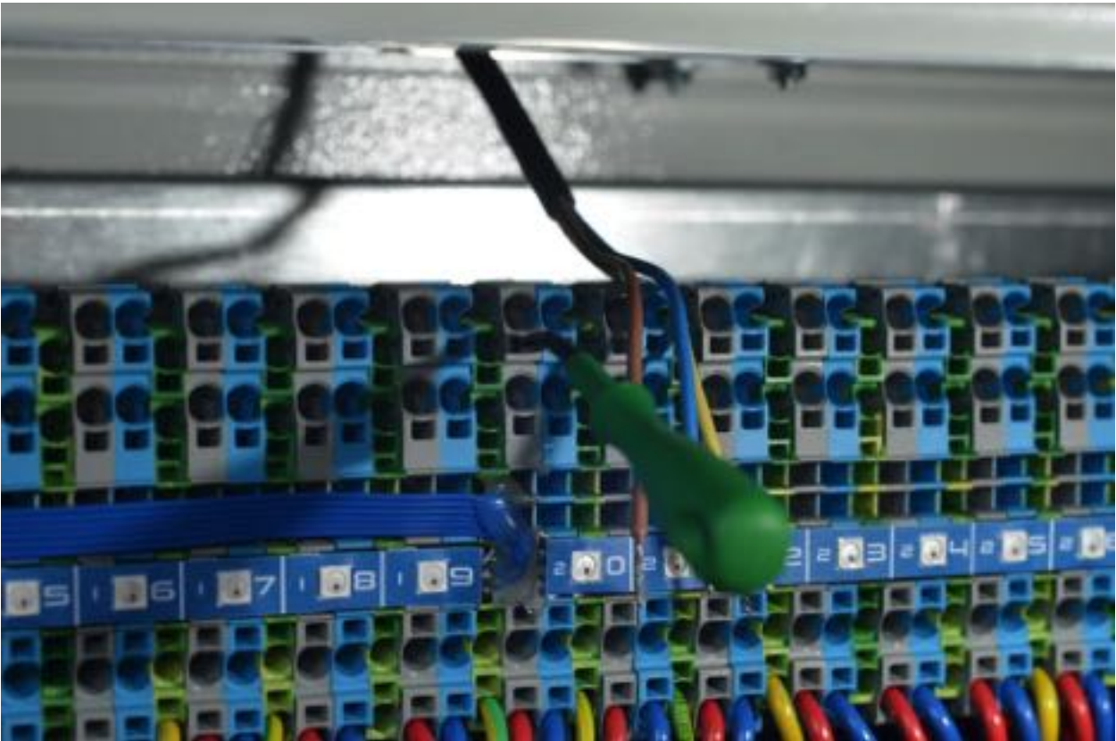
Рисунок 2.3.16. Инструмент для монтажа кабеля вставлен в клемму.
