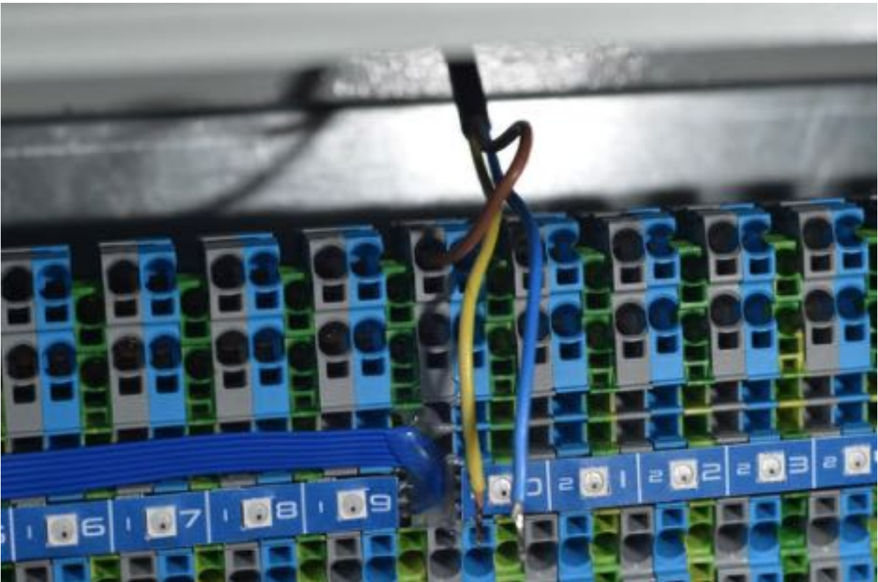
Рисунок 2.3.18. Подключен кабель (фаза) на выводе.
